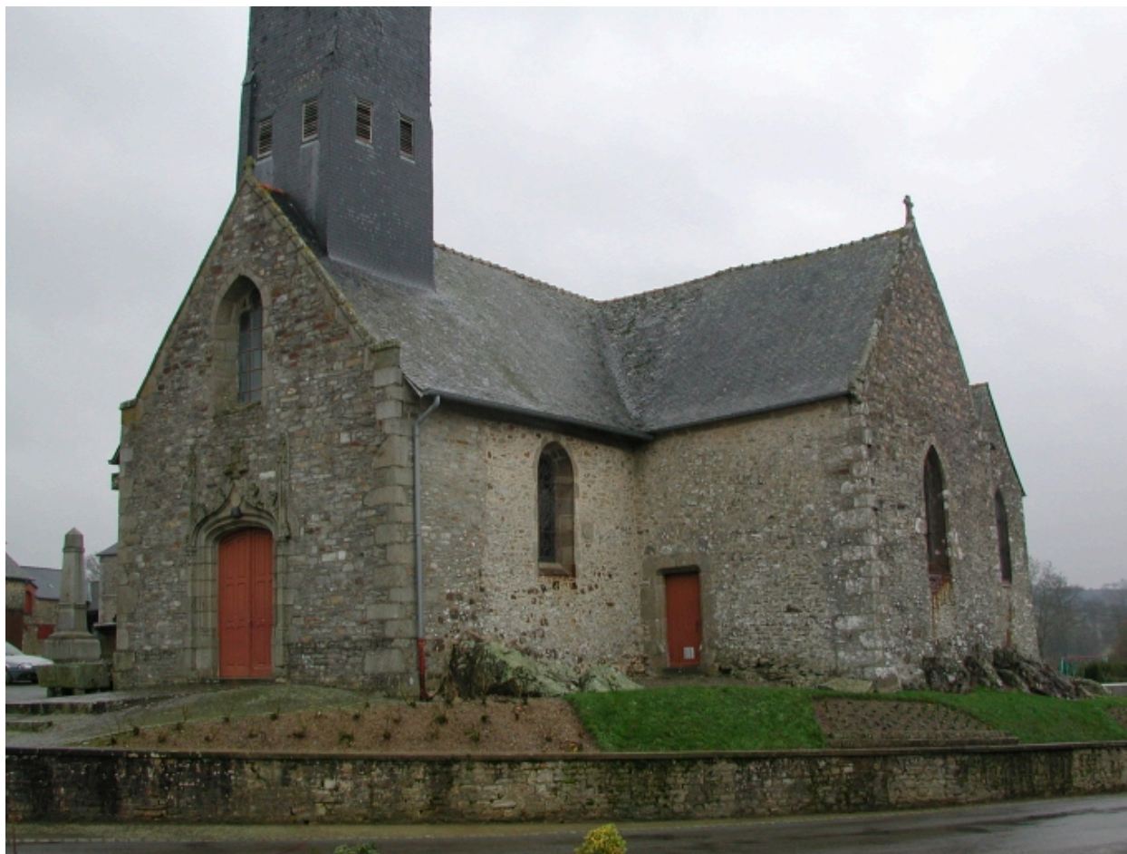
Façade latérale sud
