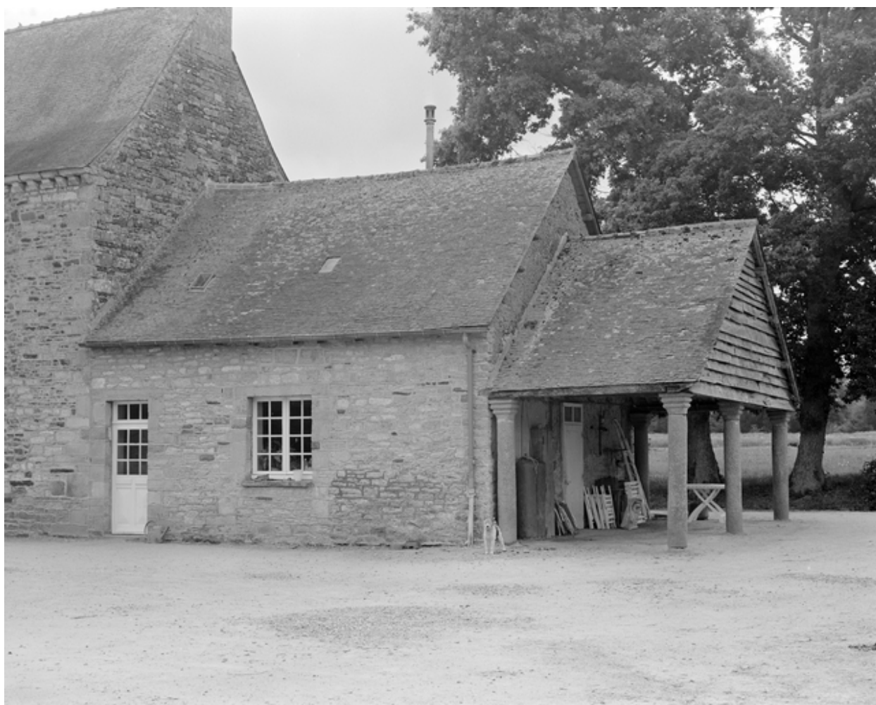
Hangar à colonnes
