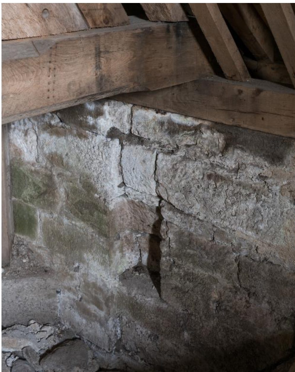
Vue de détail : vestige d'empochement en partie haute du mur ouest du croisillon nord.
