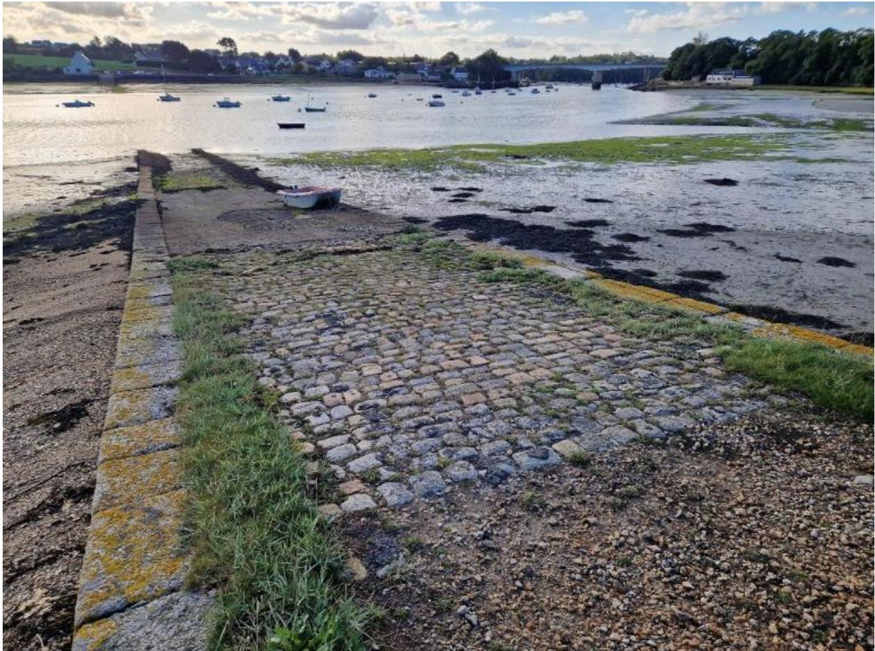
Vue de la cale Saint-Yves dans la Penzé : elle était dallée à l'origine. Cette cale a servi à mettre à l'eau et remonter les hydravions avant la construction du slipway
