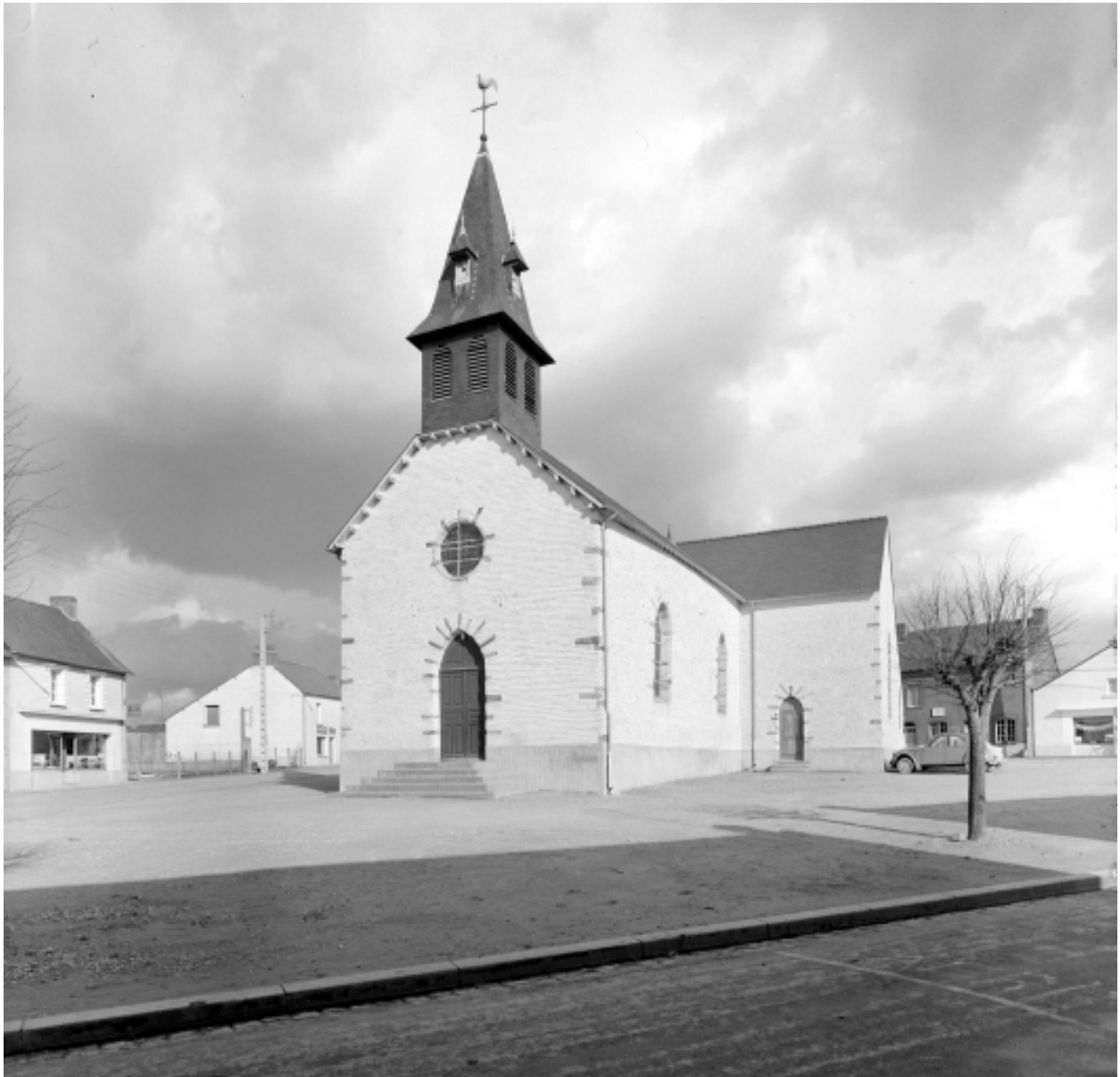
Elévation Sud-Ouest : vue générale
