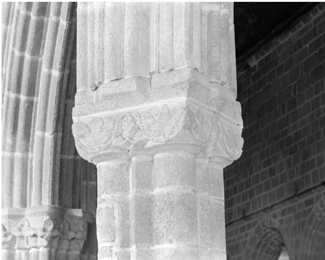
Choeur, partie est, 1ère pile sud, chapiteau
