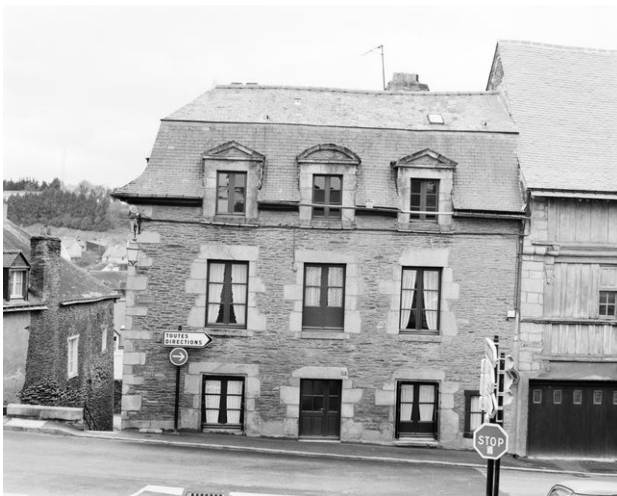
Maison : élévation nord (état en 1994)
