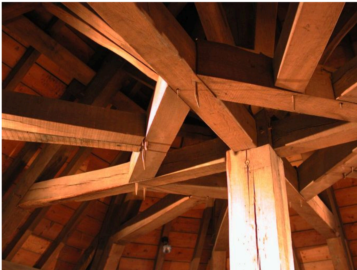
4e niveau : charpente supportant la toiture à six pans
