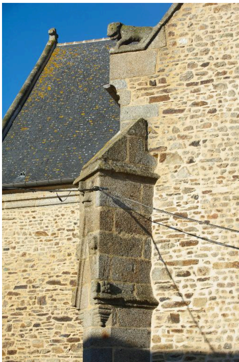
Contrefort et crossette (chevet, côté sud)
