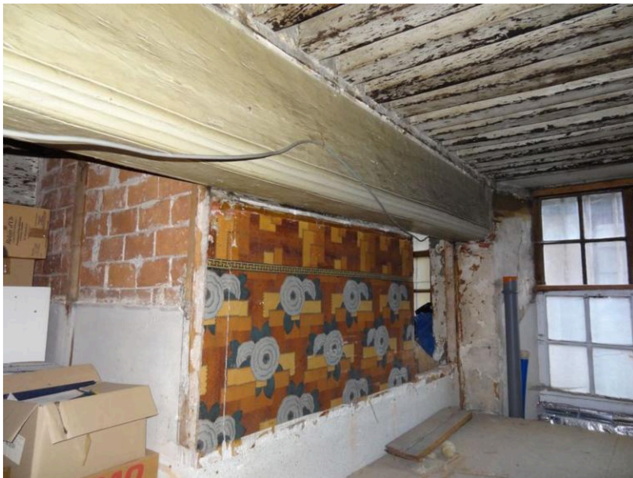
Cage d'escalier, entresol créé
