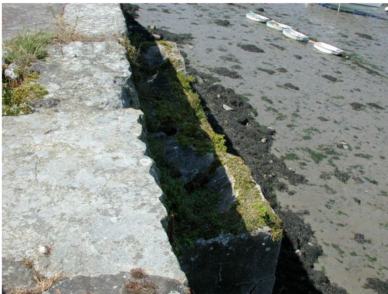
Vue des vestiges des latrines (état en 2002)
