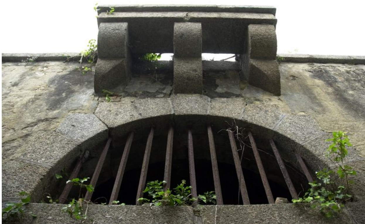
Vue du corps de garde crénelé n° 2 modifié de la pointe de Morgat ou Kador : façade est, baie et bretèche
