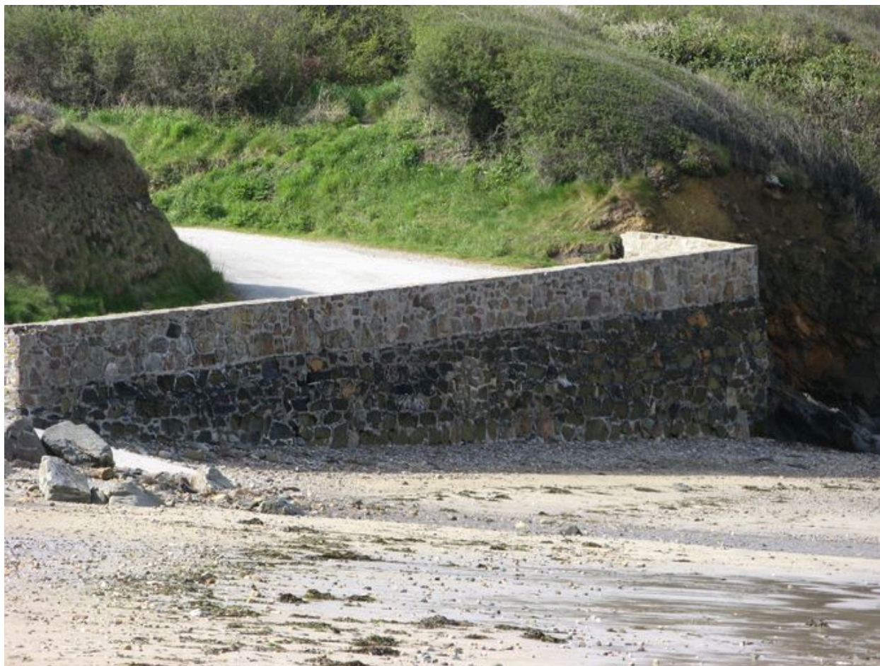
Vue générale du mur de soutènement de la plage de Goulien
