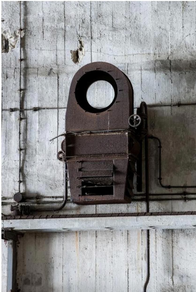
Vue d'un élément du système de chauffage et de ventilation fixé sur le mur de l'alvéole sud (emplacement pour un ventilateur en haut, un échangeur au milieu et une bouche de soufflage à lame en bas)
