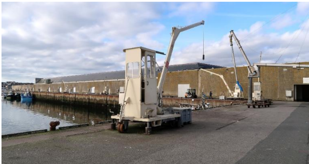
La criée de Concarneau : grues de déchargement
