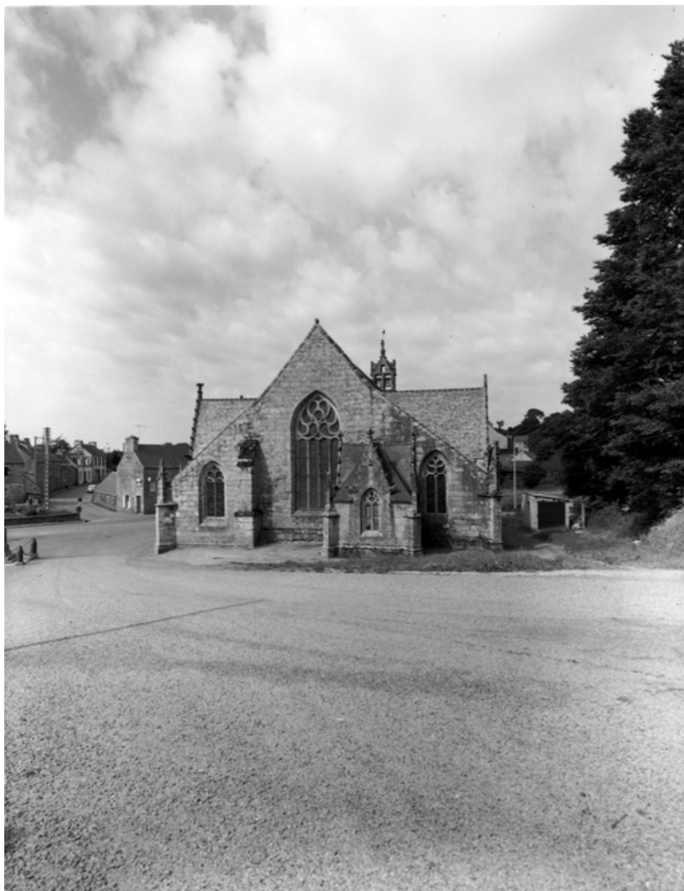
Face est : vue d'ensemble
