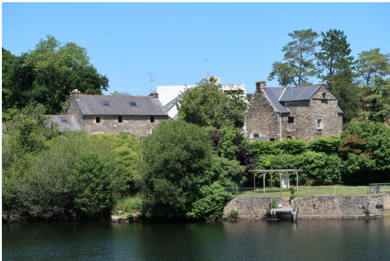
Vue des édifices situés au nord de l'étang (état en 2022). L'édifice de droite - restauré - semble datable du 16e siècle
