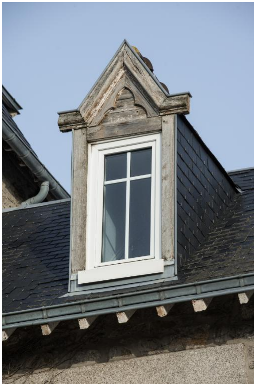
Détail sur une lucarne.
