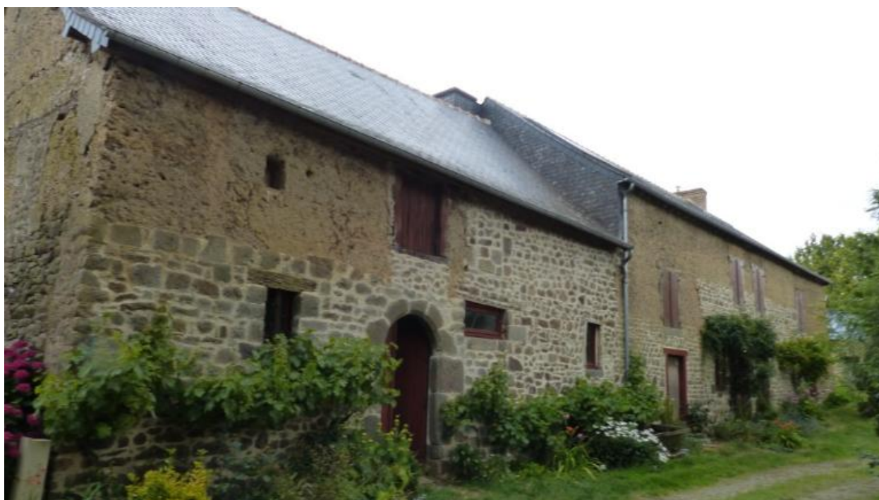
Vue générale sud
