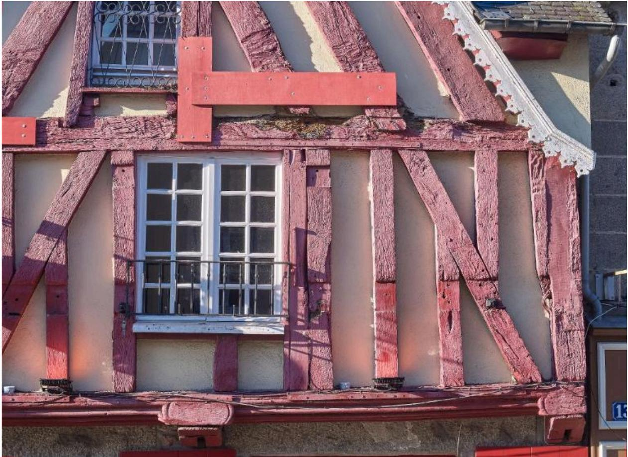
Dégradation du pan de bois camouflée en partie par des planches ou un remplissage pour le poteau cornier.
