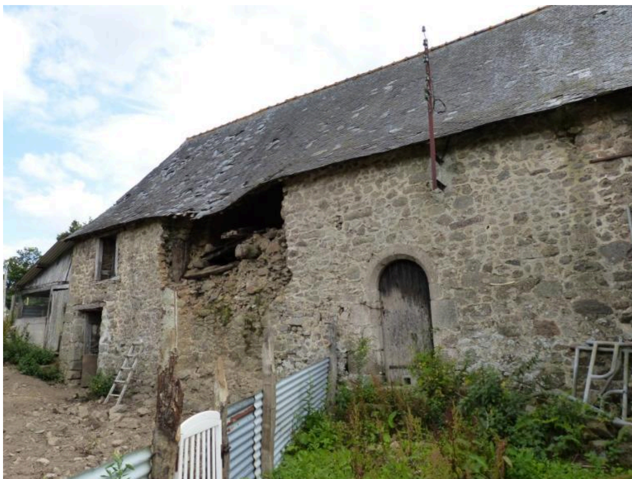
Vue générale nord, Ferme, Bêlême (Hédé-Bazouges)
