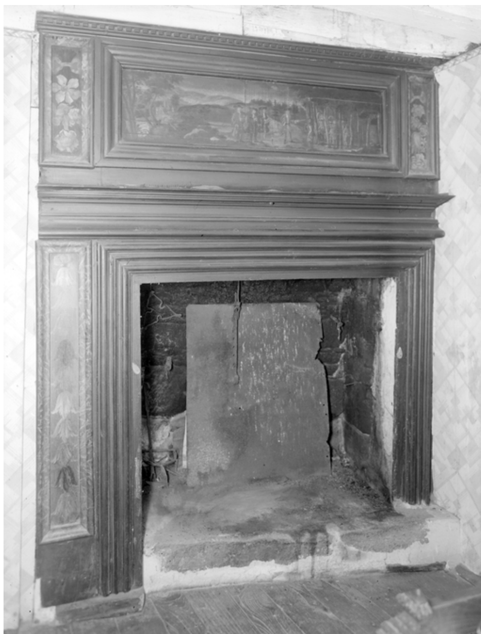
Maison B, cheminée dans la chambre à l'étage contre le mur nord.
