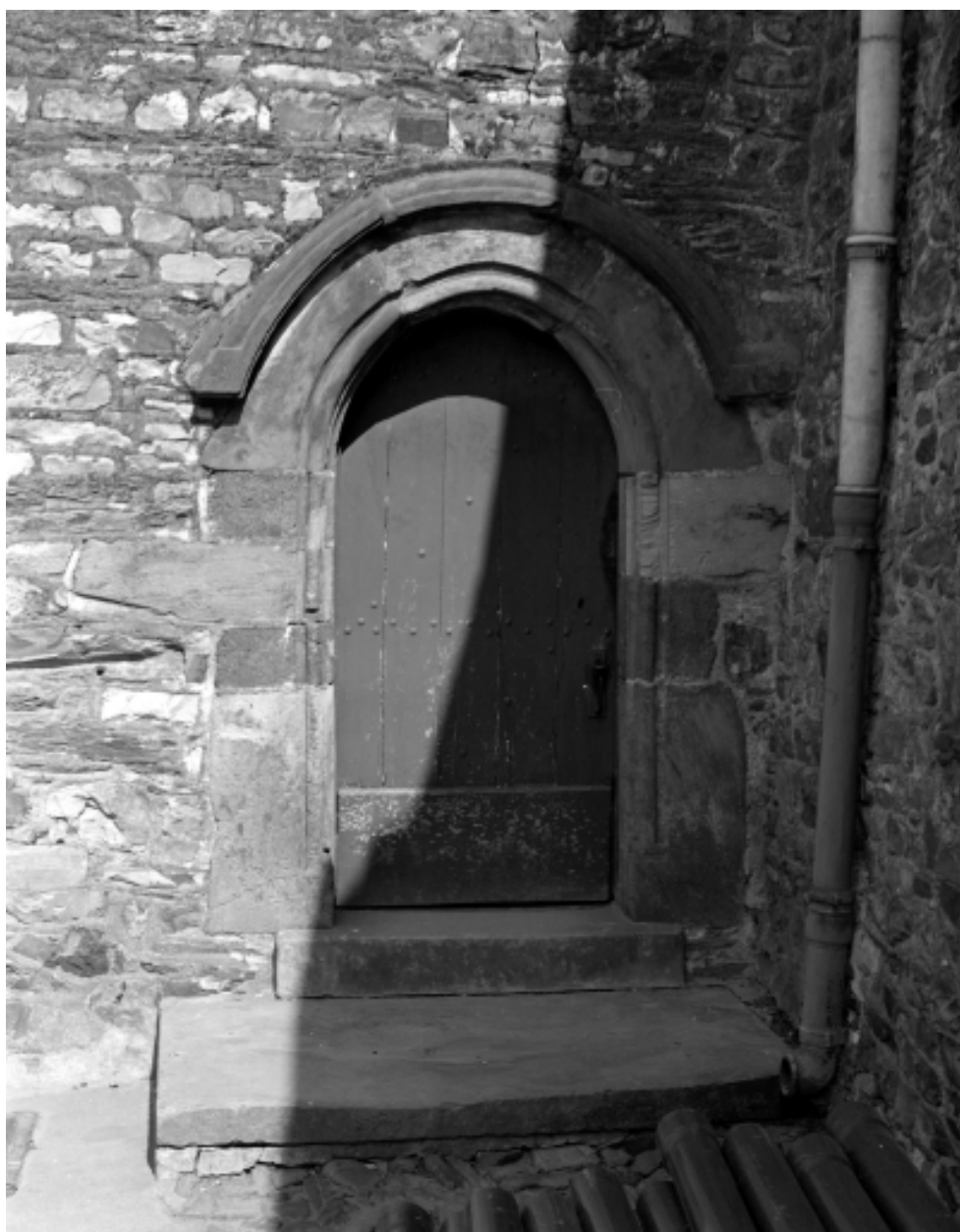
Transept nord, porte, vue générale.
