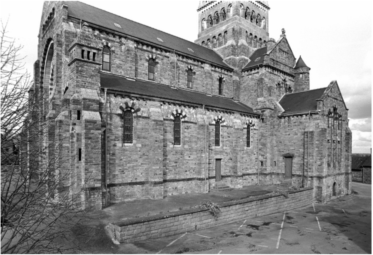
Elévation sud-ouest ; vue générale
