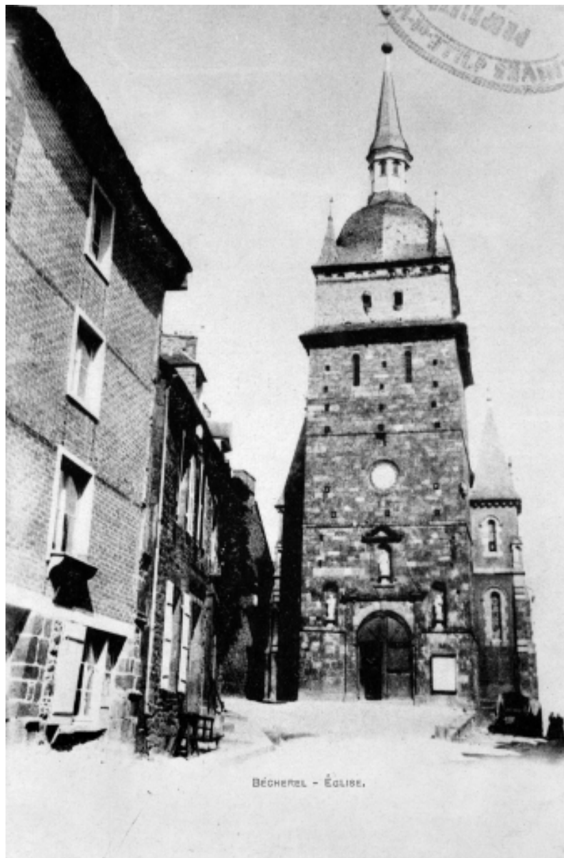
Elévation Ouest : vue générale. avant 1898.
