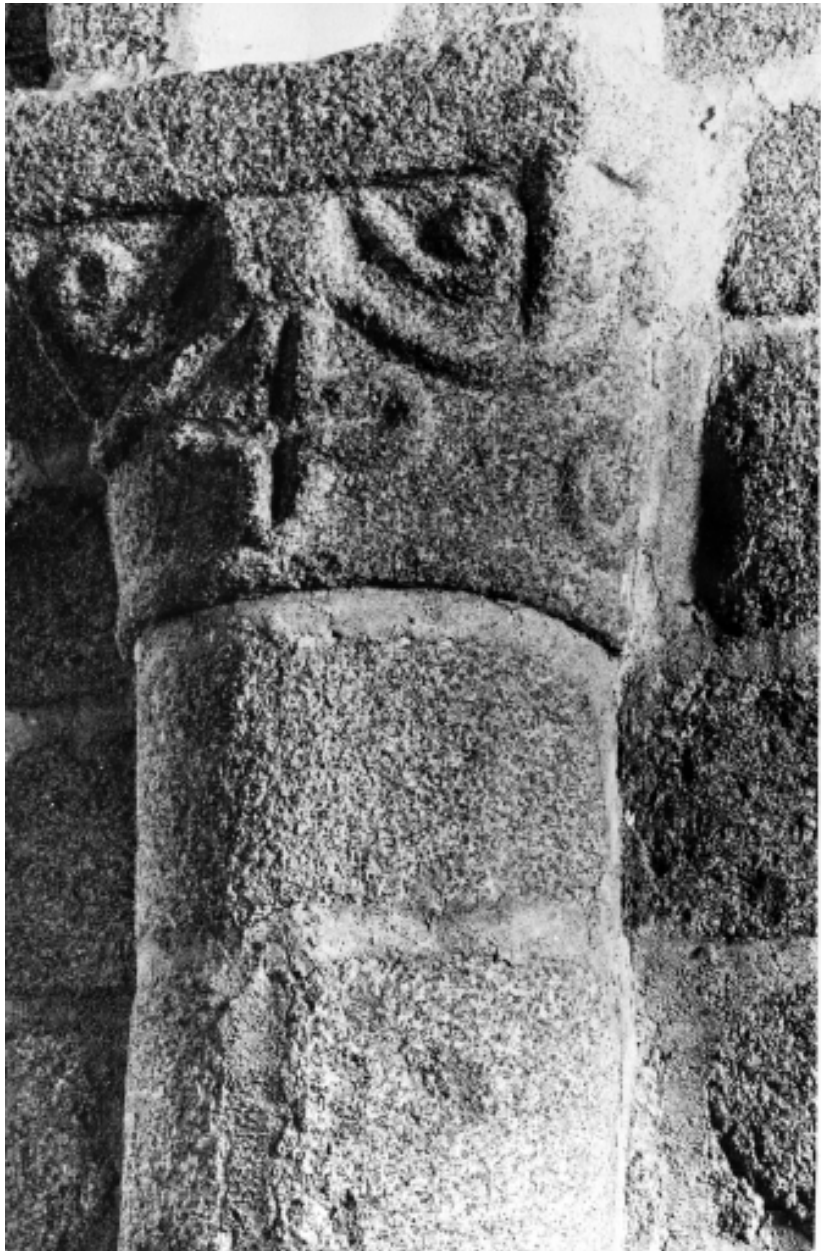
Intérieur : détail de la pile n°3, face ouest.
