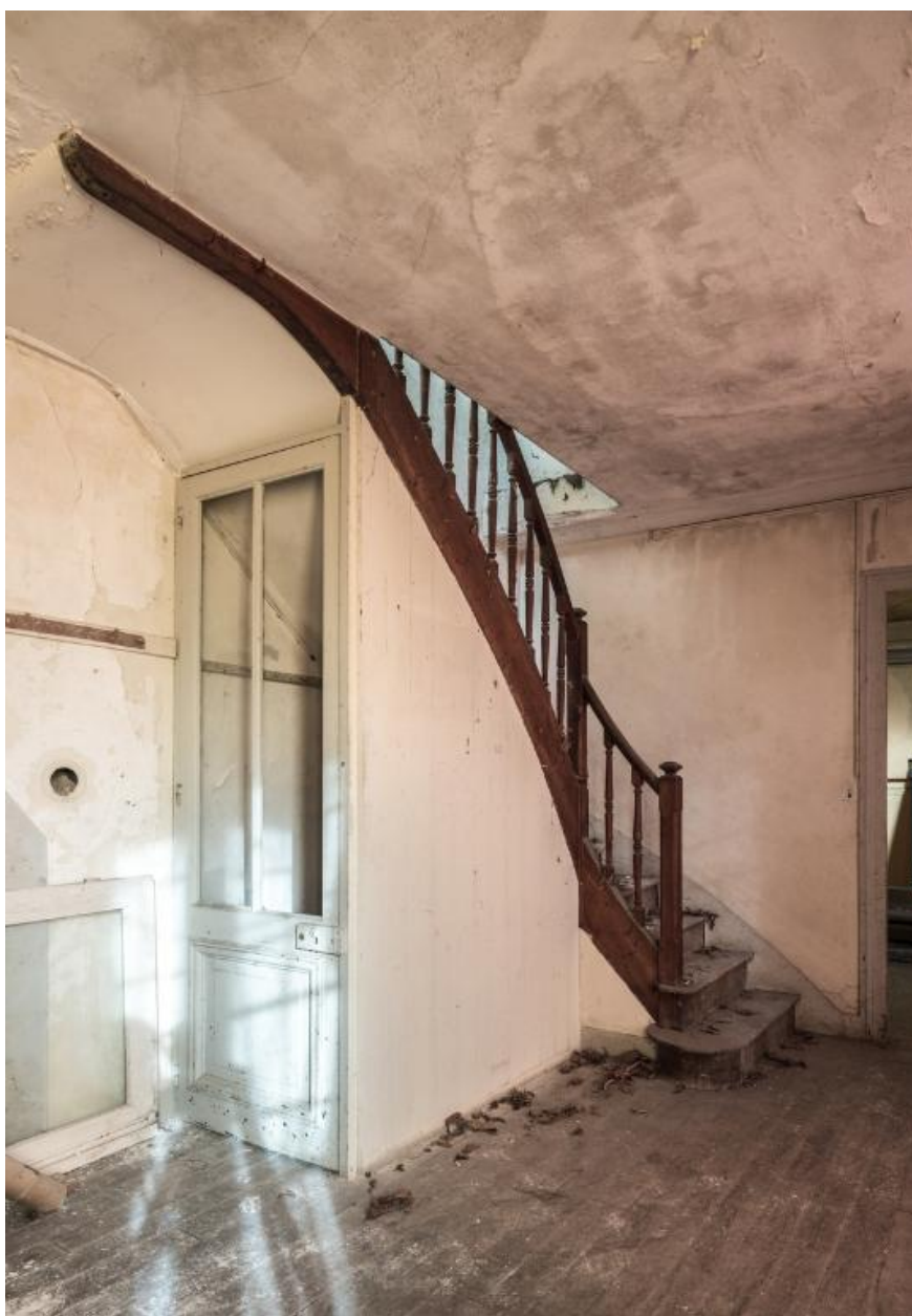
Dégagement et escalier.
