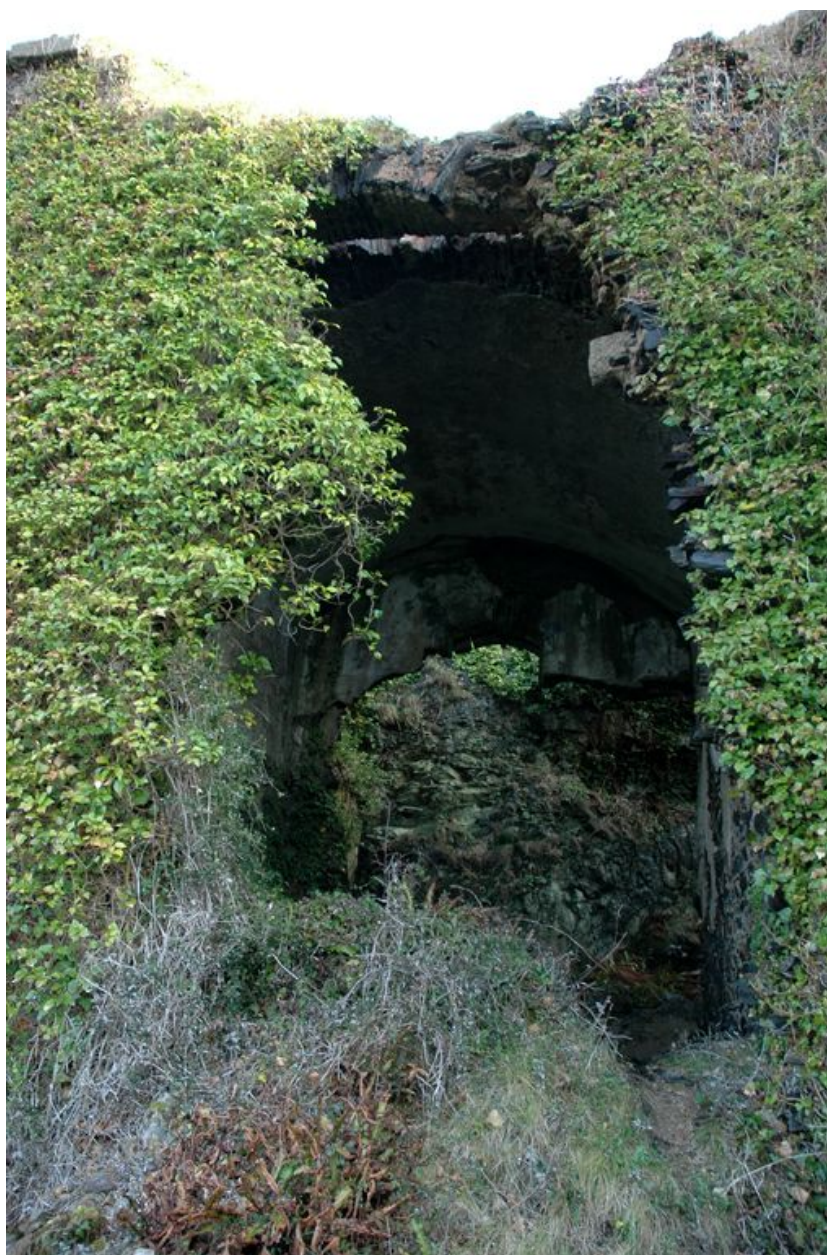
Vue générale de la caserne défensive Robert
