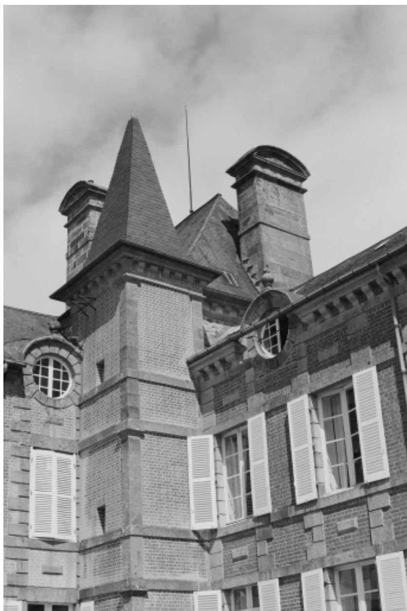
Détail de la tourelle d'angle
