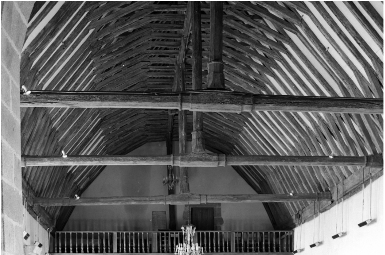
Intérieur, nef, charpente : vue générale.
