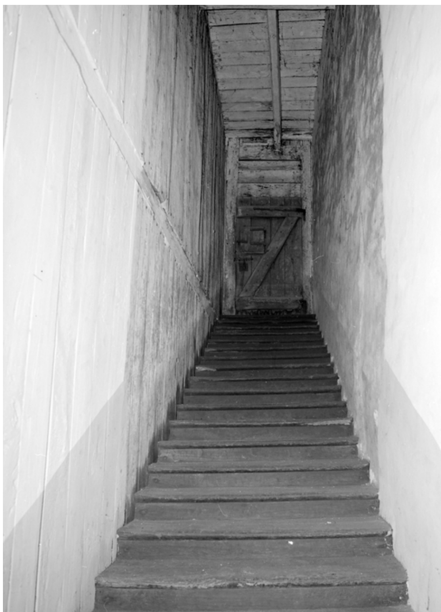
Escalier, vue générale.
