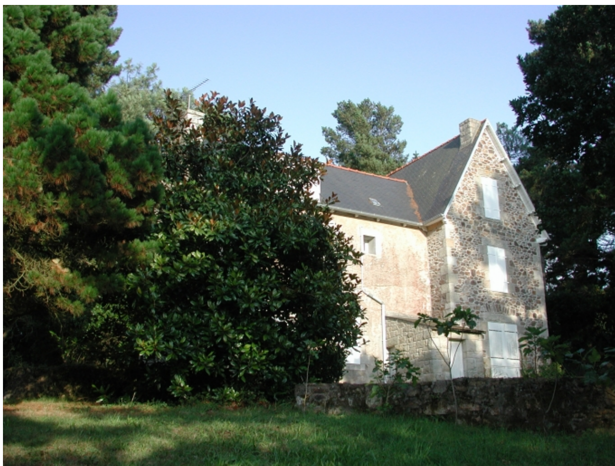
Vue d'une maison en front de mer du Trieux, Landiris
