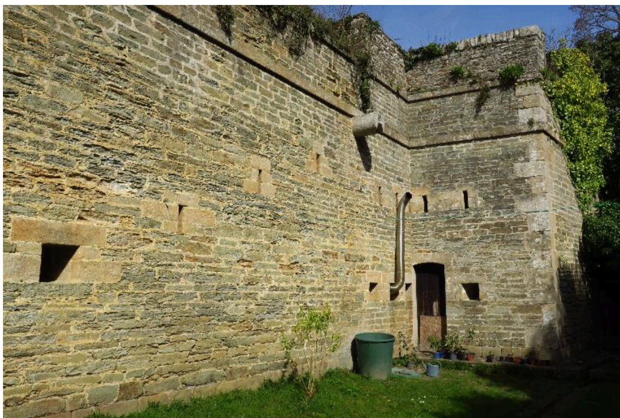
Le Palais, enceinte urbaine, réduit A, bastionnet de gauche.
