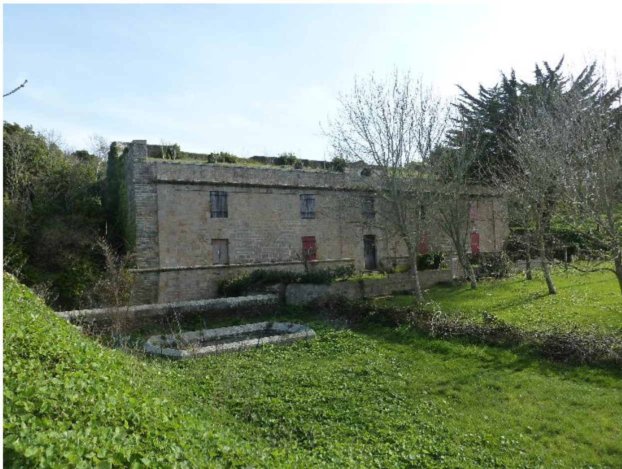
Le Palais, enceinte urbaine, réduit A, vue depuis la courtine 18.
