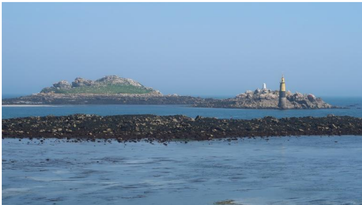
Amer de l'île Pigned et tourelle Ar Chaden
