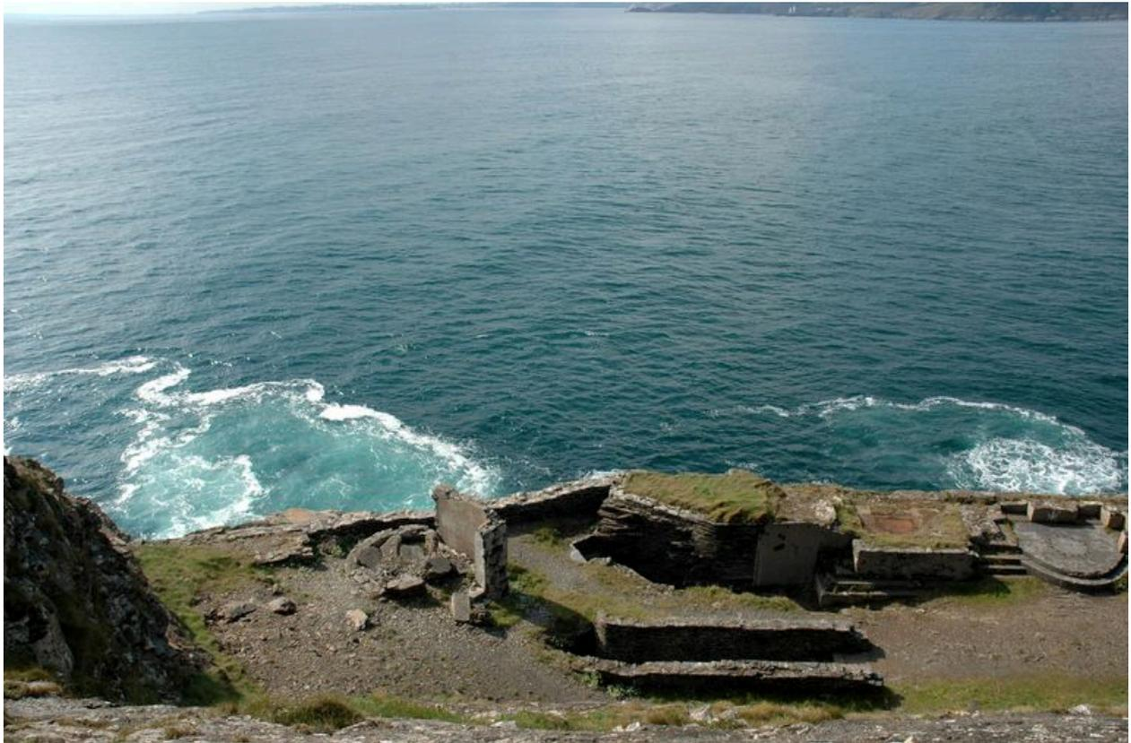
Vue de la partie ouest de la batterie de l'îlot des Capucins. Derrière le parapet, on distingue de gauche à droite : l'accès à un abri pour projecteur situé au ras de l'eau, les vestiges d'un autre et deux plateformes pour canon (dont une pour 47 mm TR)
