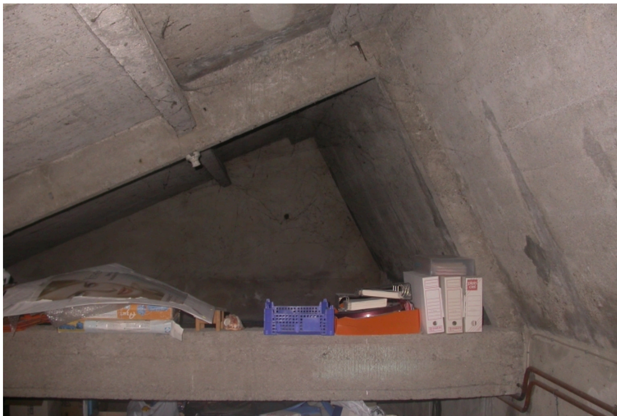
Charpente en béton armé
