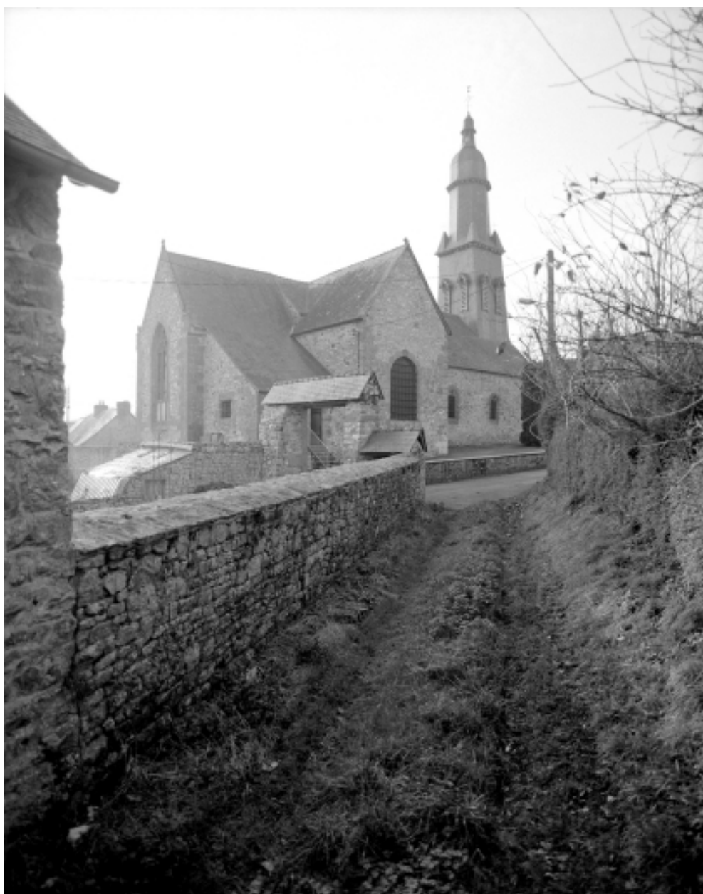
Elévation Nord : vue générale
