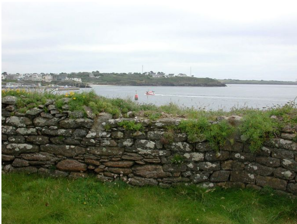
Vue de détail du parapet (état en 2006)
