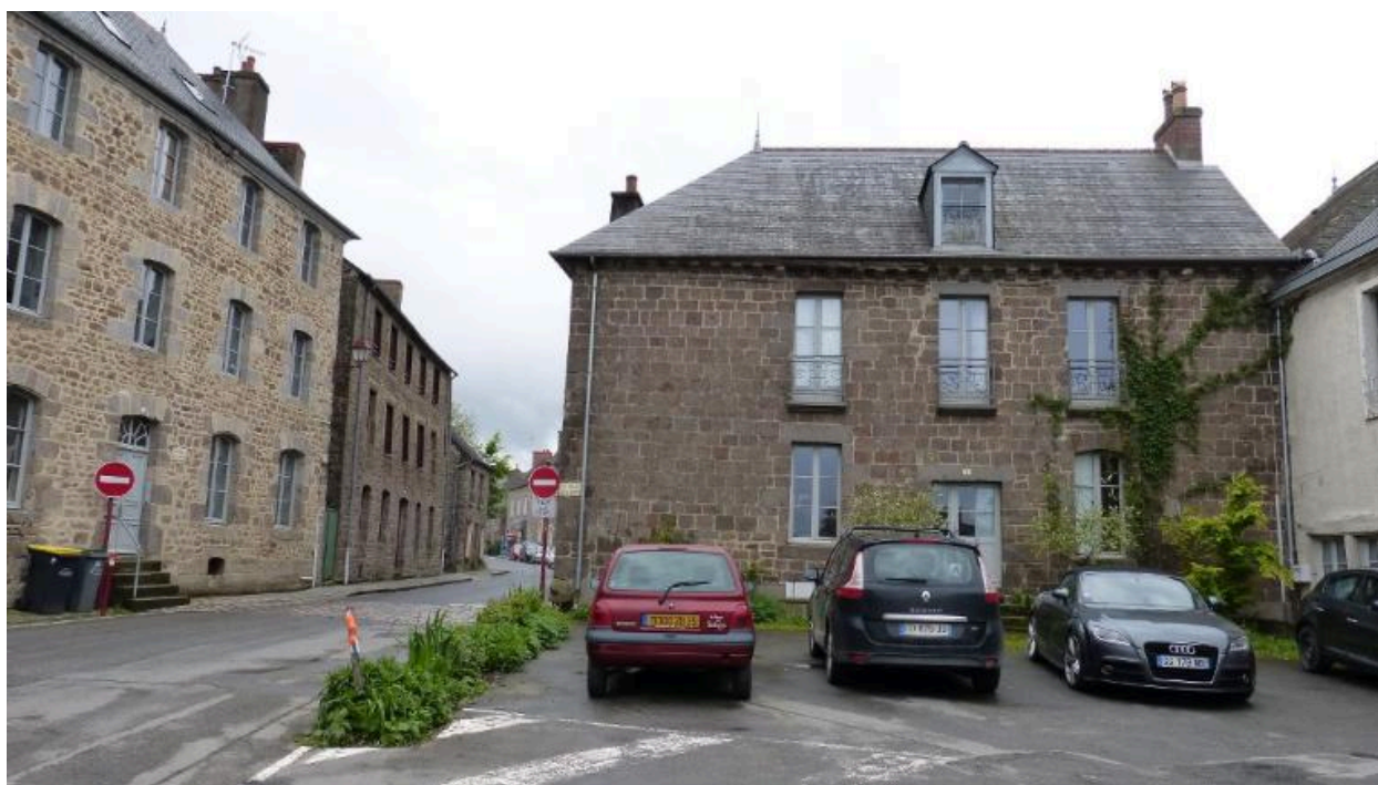
Vue de la façade nord
