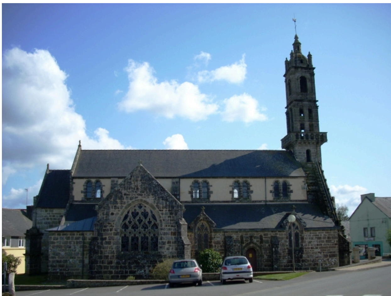
Etern, église paroissiale Saint-Etern : élévation nord
