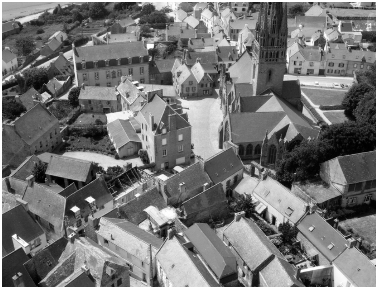
Vue aérienne, vue vers l'est
