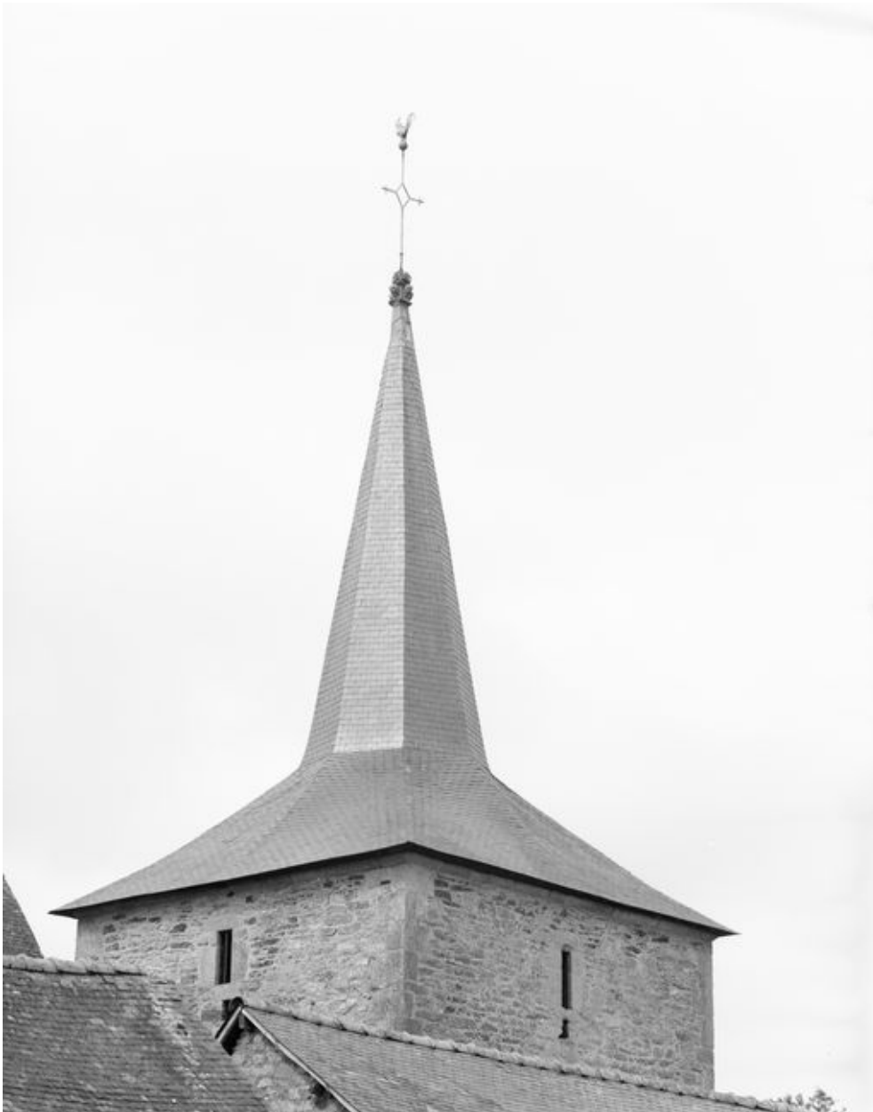
Chapelle : partie supérieure du clocher vue du sud-est (état en 1991)
