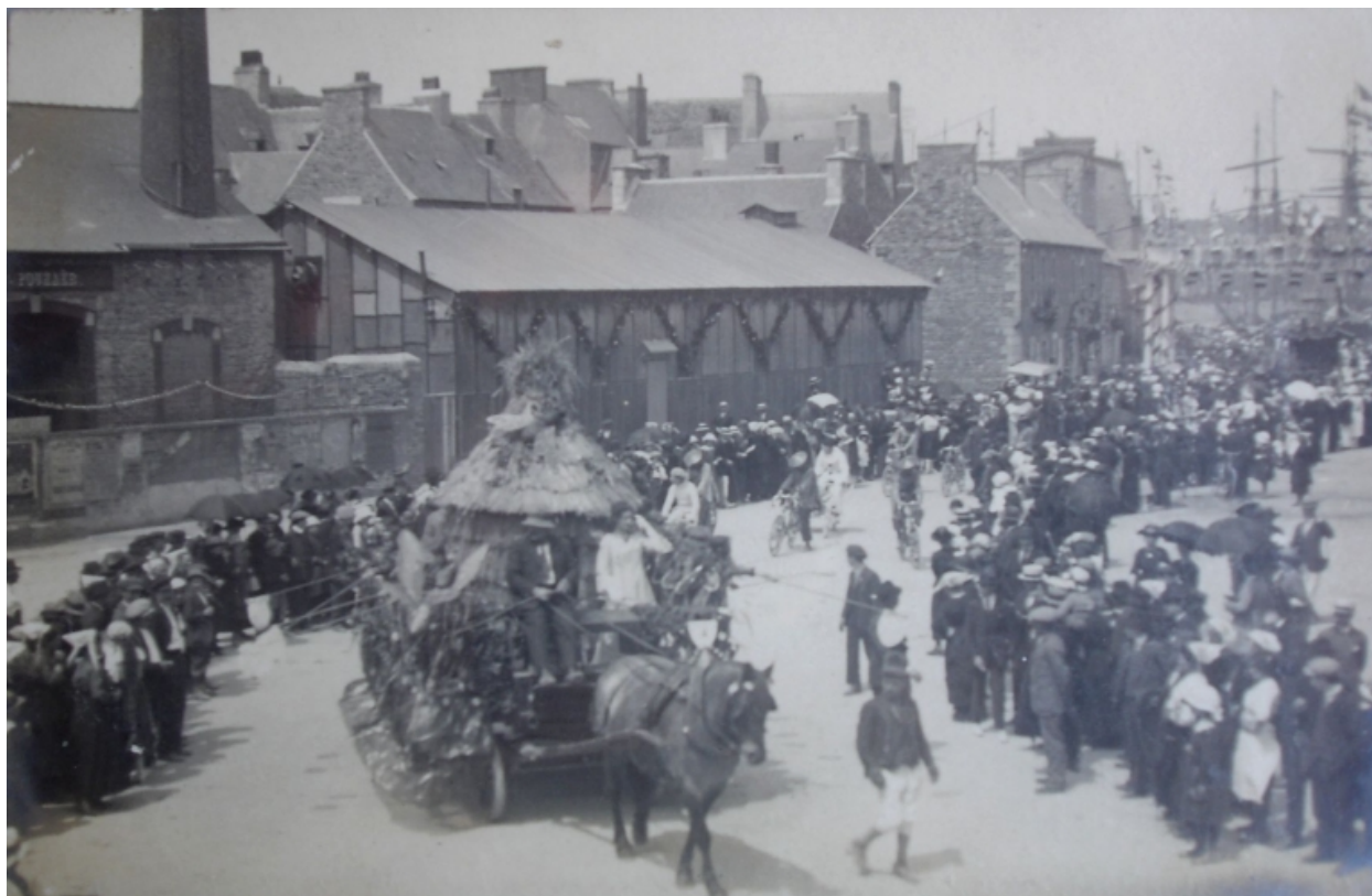
En front de port : l'usine électrique et le cinéma en 1921 (carte postale, cliché Torty, collection particulière)
