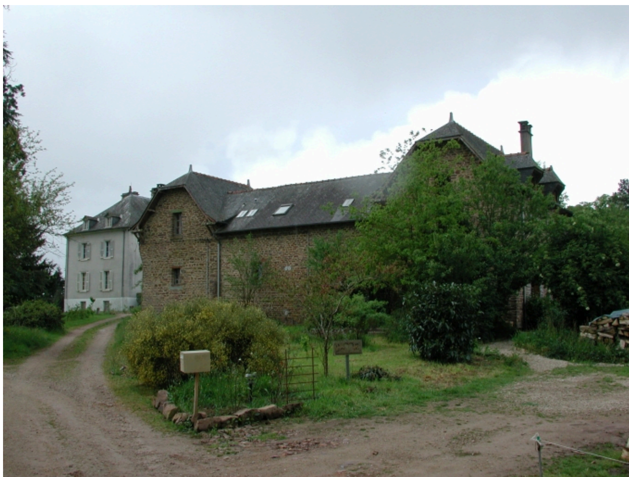
Vue de situation nord-est
