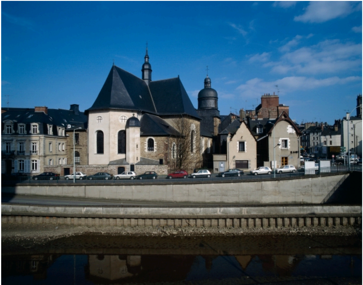
Elévation ouest : vue de situation
