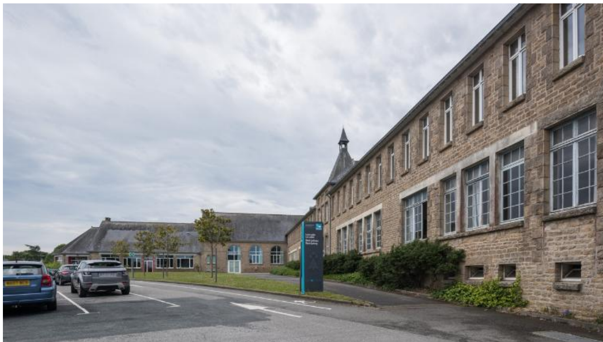
Vue d'ensemble, prise du nord-est. Georges-Robert Lefort, architecte, 1929
