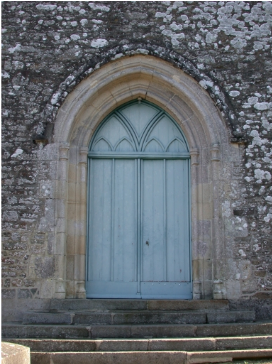
Façade ouest, portail
