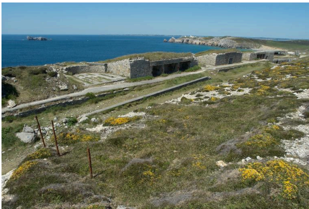
Vue générale de la batterie de mortier
