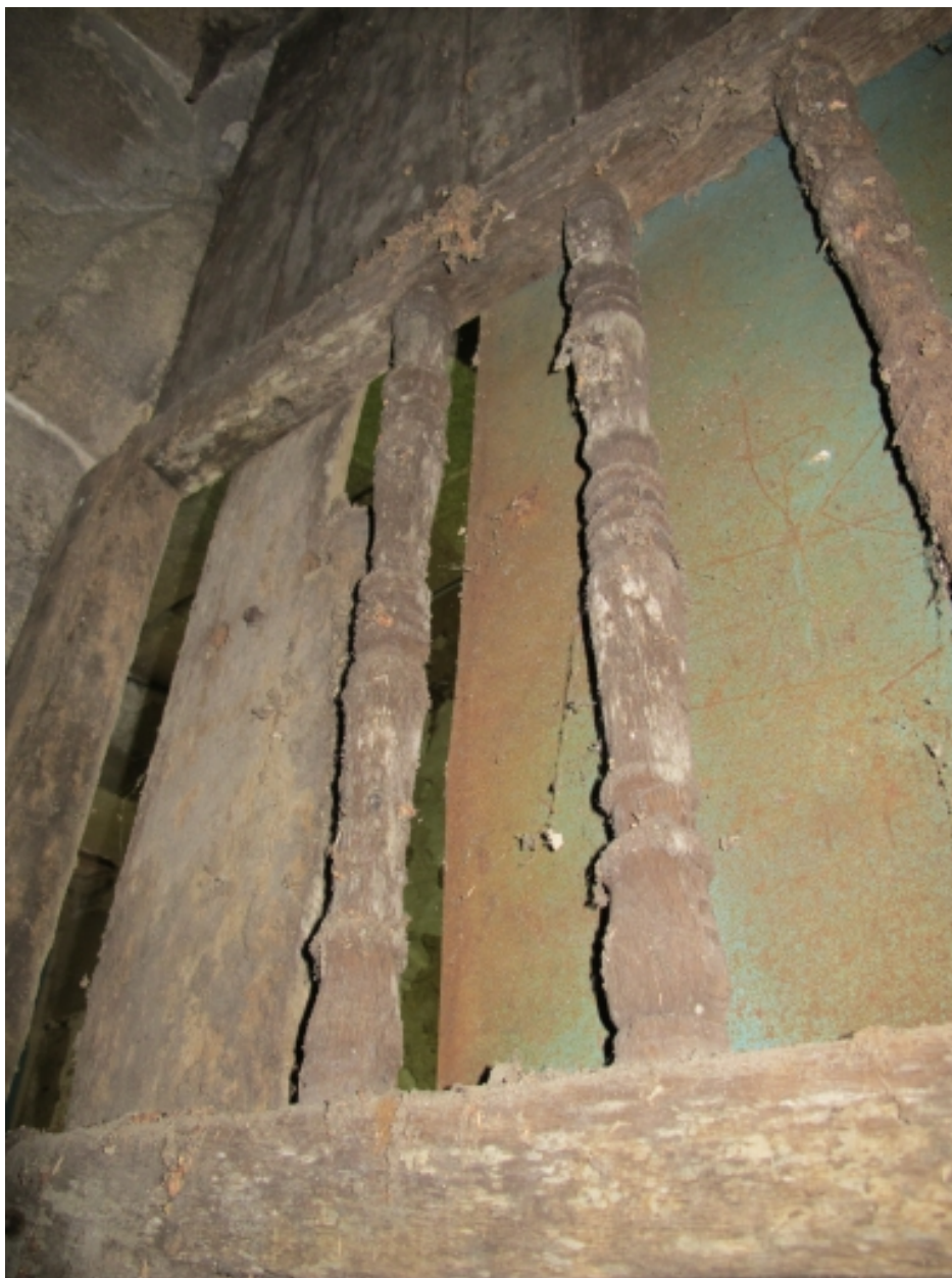
Balustrade en bois située au rez-de-chaussée de l'escalier
